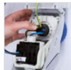
Connessione del conduttore di terra senza viti, max Ø 4mm; Ø 10mm su 32A.
